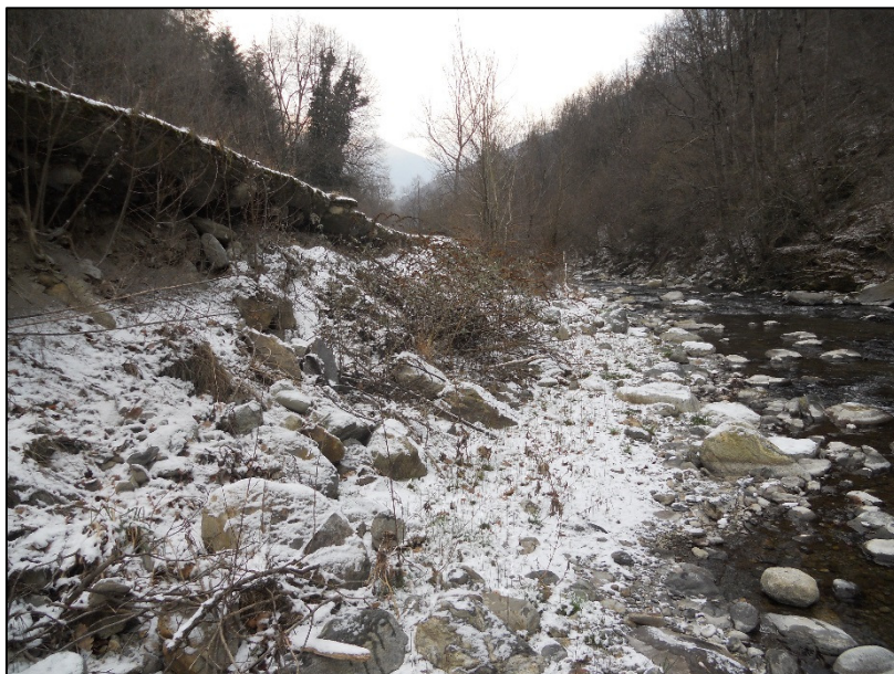
Figura 13 Sponda destra erosa con sedime stradale a sbalzo
