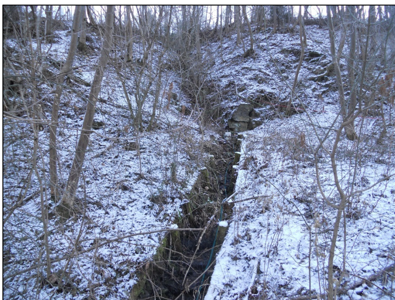
Figura 8 Canaletta in legname parzialmente danneggiata
