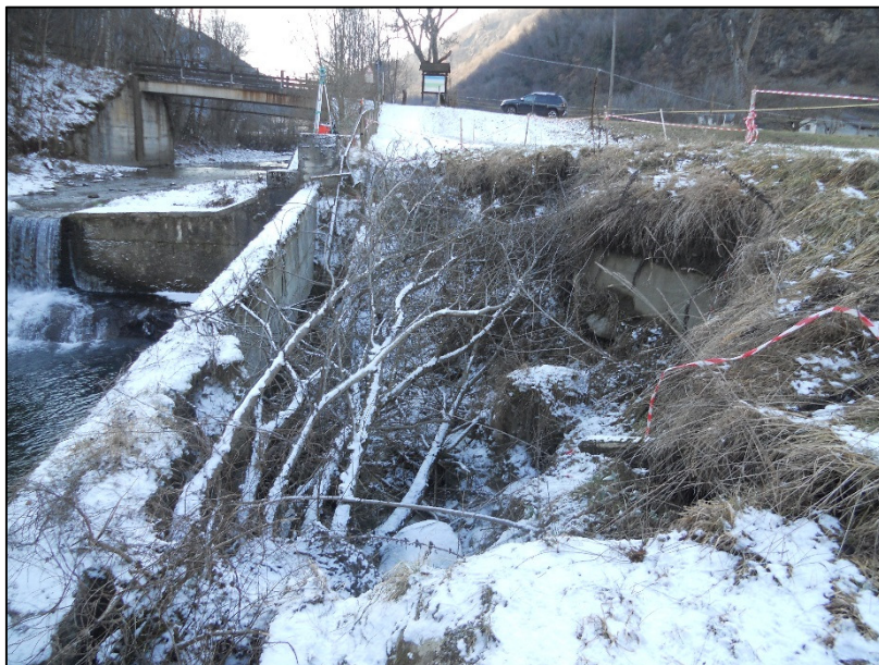
Figura 6 Terrapieno d'argine completamente svuotato
