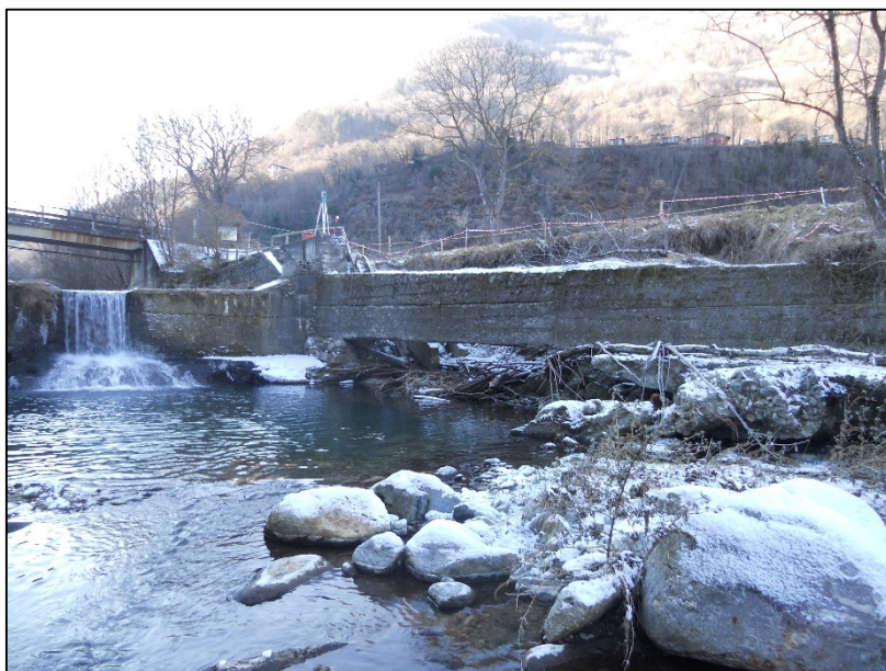
Figura 7 Muro in c.a. "appeso" in seguito al cedimento della sponda
