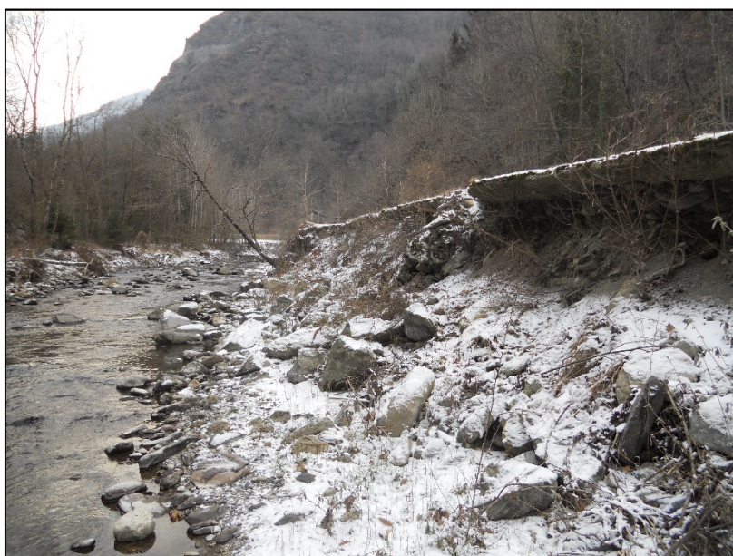
Figura 14 Sponda destra erosa con sedime stradale a sbalzo
