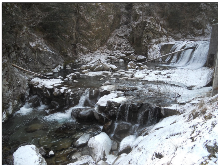
Figura 15 Soglia di monte deteriorata
