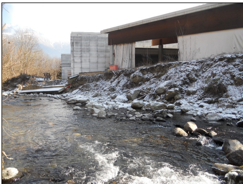
Figura 11 Muro in cemento armato crollato di proprietà della ditta Monvania Srl
