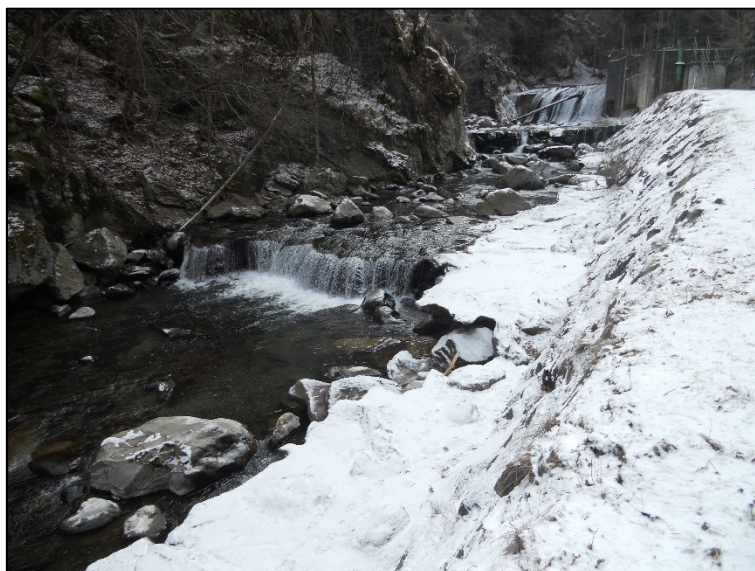
Figura 16 Soglia di valle deteriorata
