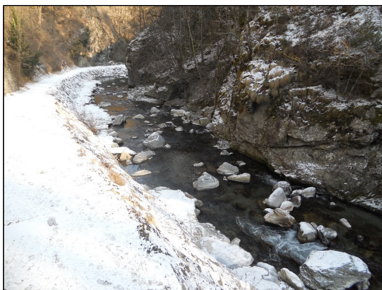
Figura 17 Scalzamento al piede del selciatone
